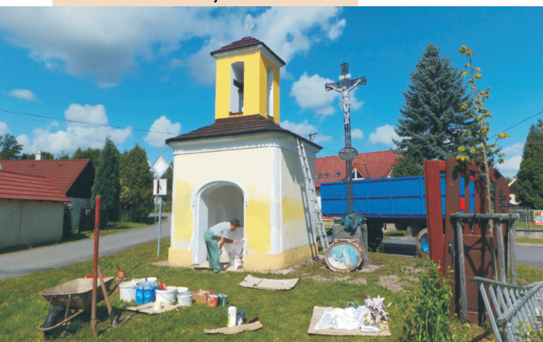
Probíhá oprava interiéru kapličky na Údraži, "...a budou i nové šindele na střechu..."
